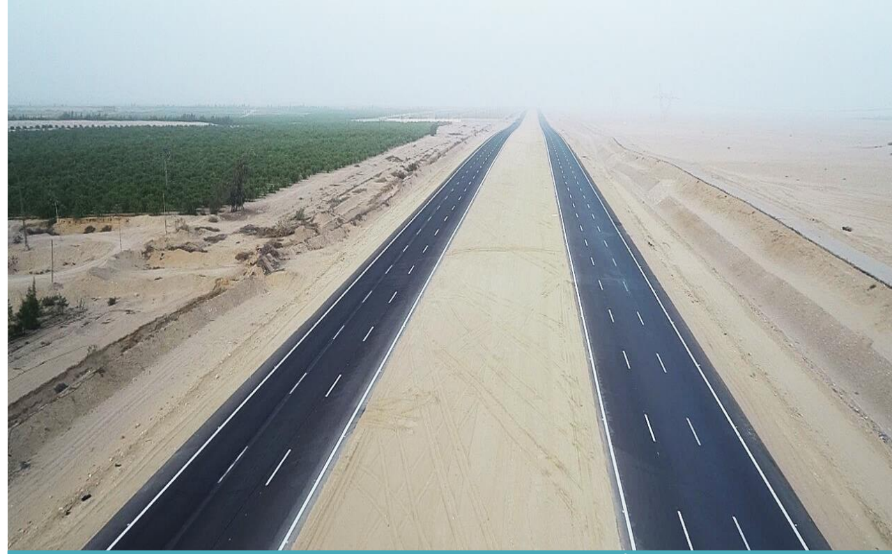
طريق النفق / رأس النقب بطول ٢٣١ كم (بتكلفة ٣,٢ مليار جنيه)
