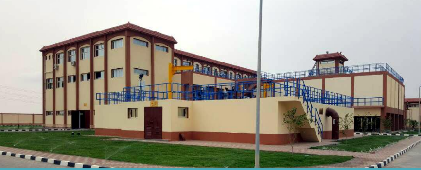
محطة المياه المرشحة
