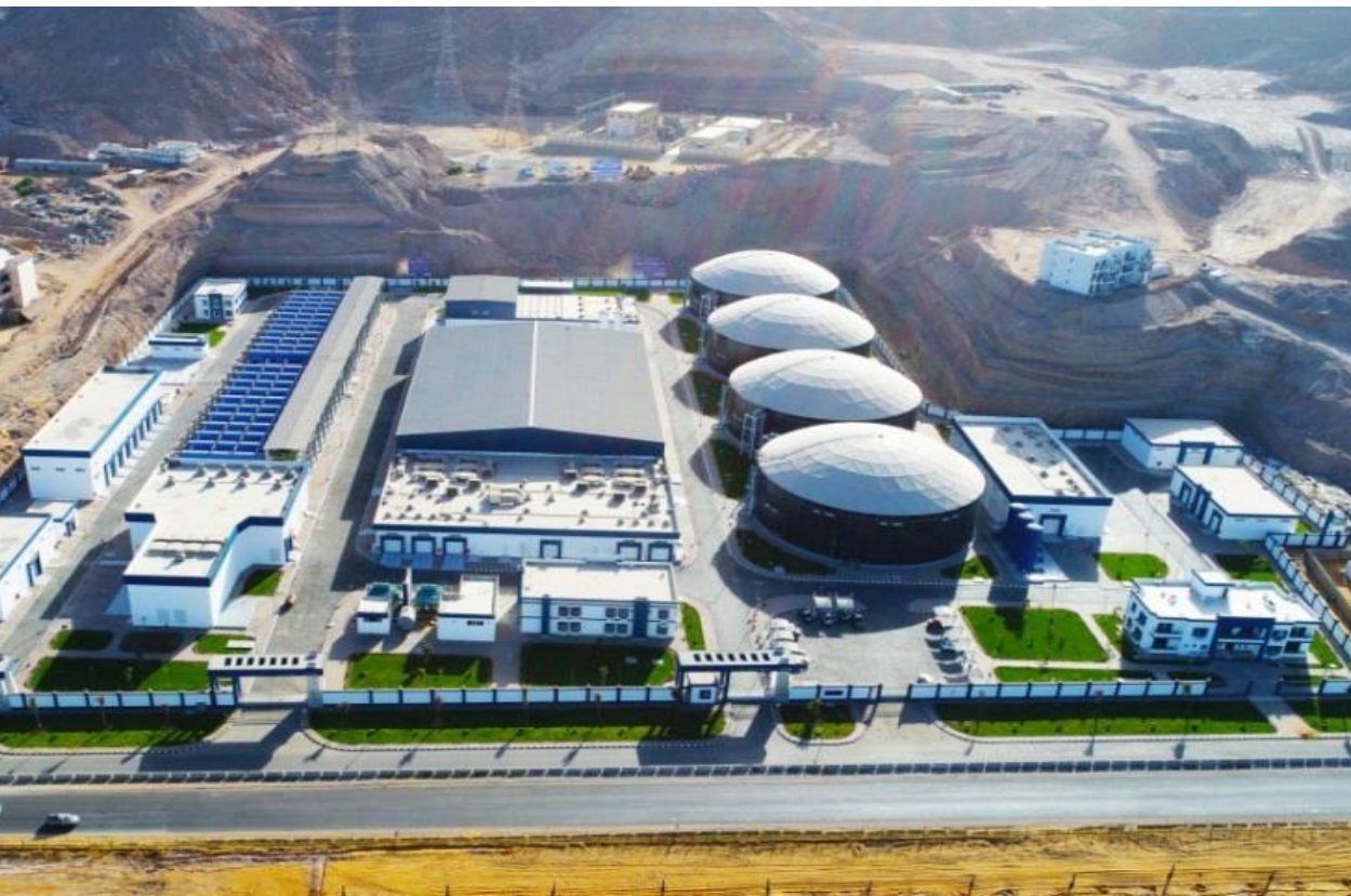
محطة تحلية مياه البحر بمدينة الجلالة (١٥٠ ألف م ٣ / يوم)
