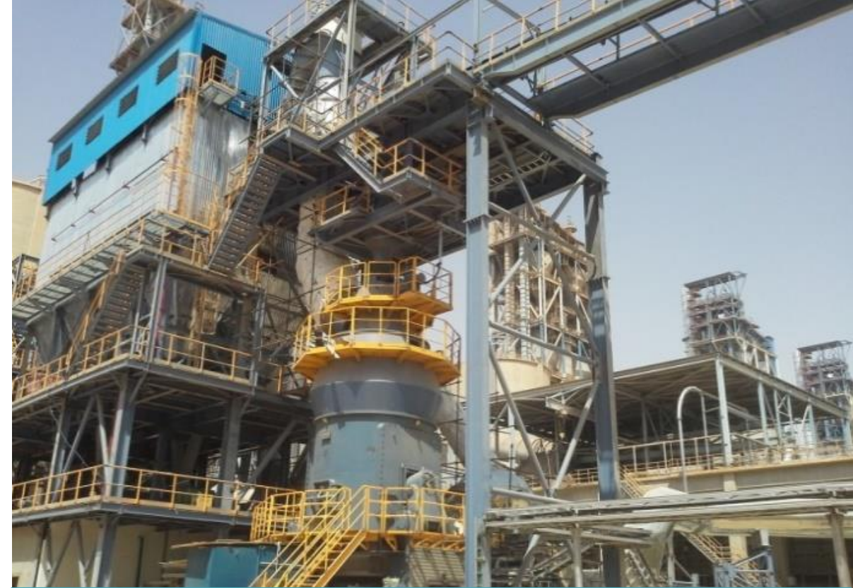
مصنع إنتاج الطوب الأسمنتي بجبل لبنى - شمال سيناء
