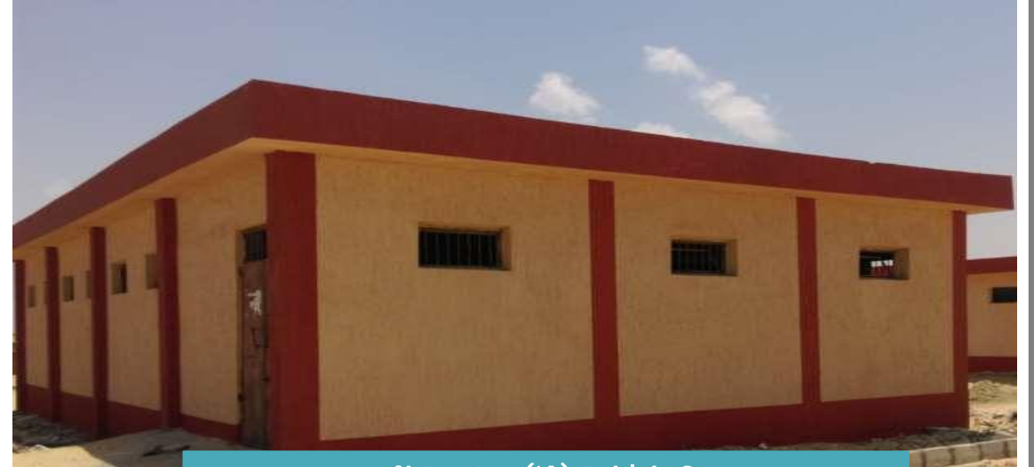
رفع كفاءة (١٨) مبنى قائم
