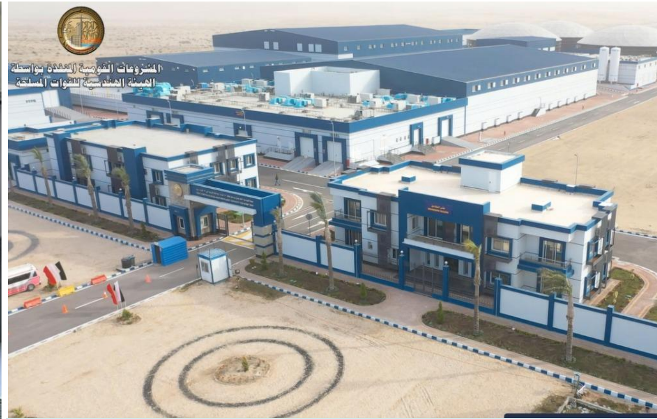
محطة تحلية مياه البحر بشرق بورسعيد (بطاقة ١٥٠ ألف م ٣ /يوم)
