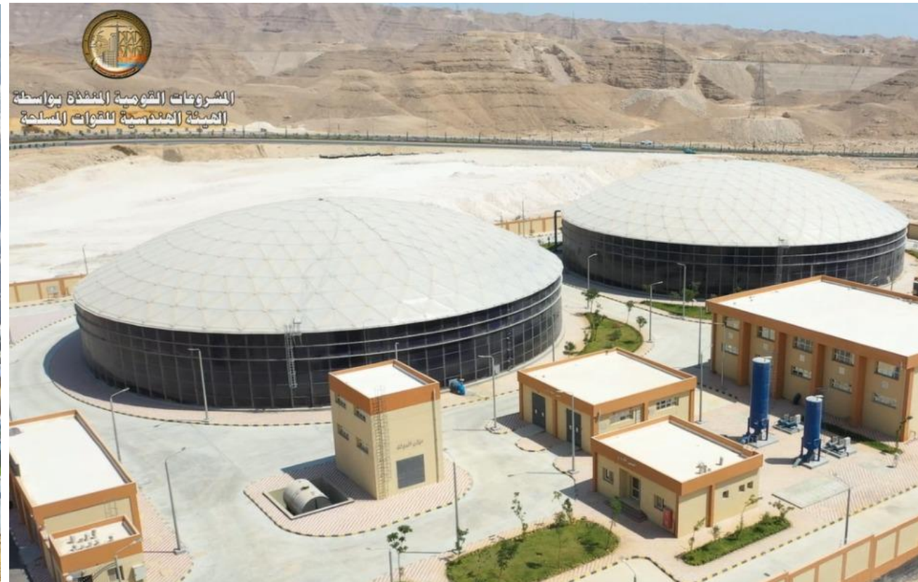
محطة رفع المياه بمدينة الجلالة
