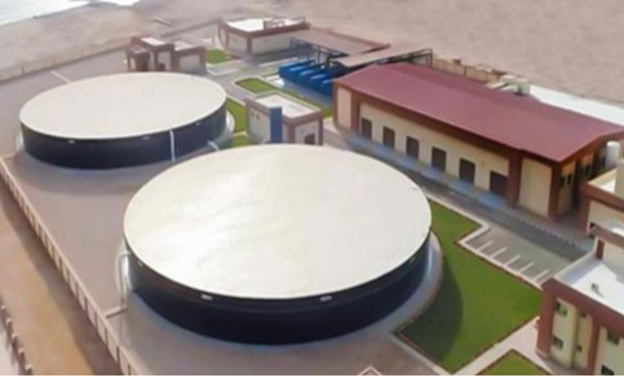
محطة معالجة الصرف الصحي بمدينة الطور (بطاقة ١٠ آلاف م ٣ /يوم)
