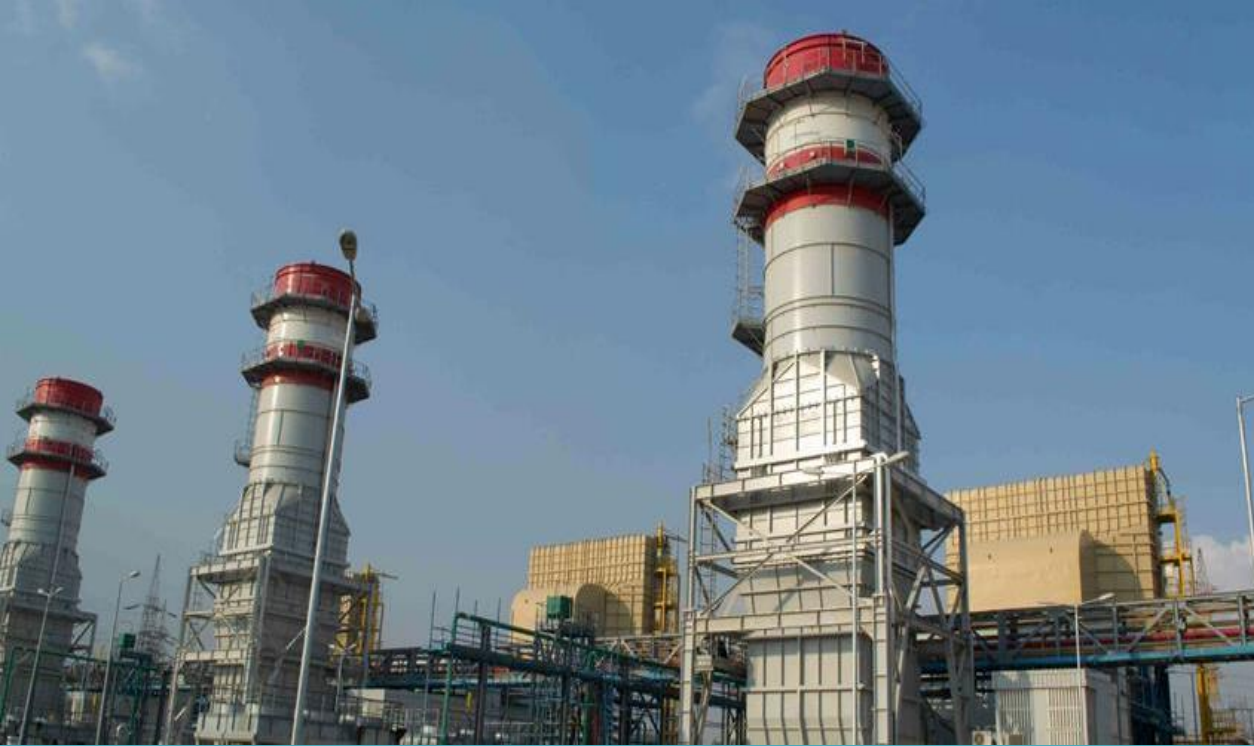
محطة توليد كهرباء عتاقة الغازية بمحافظة السويس
